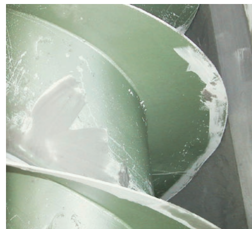
Šnekový žlab s nanesenou vrstvou nové výstelky před uvedením do provozu
