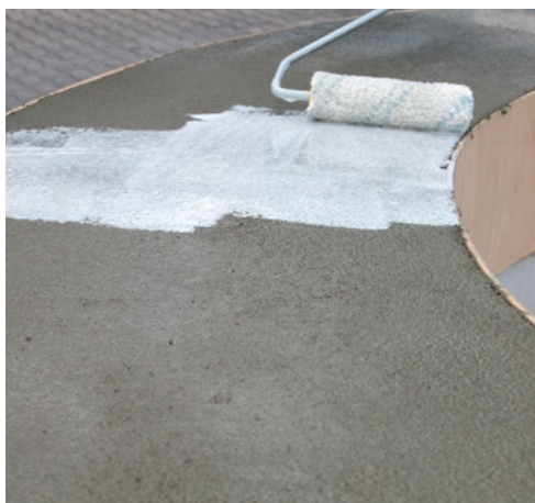
Nanášení produktu MC-DUR 1177 WV-A válečkem na matně vlhkou nanesenou vrstvu
