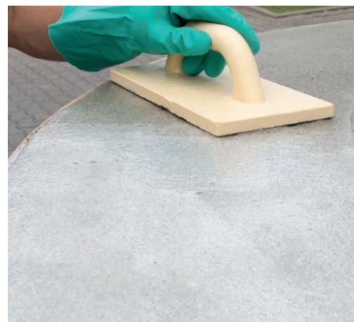
Zpracování produktu MC-DUR 1177 WV-A do povrchu
